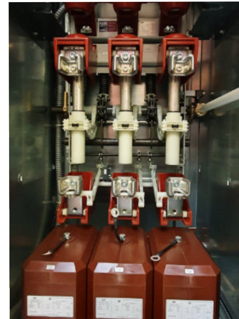
In die SAM integriert werden meist Schublasttrennschalter CZ3. Die früher von ABB/Calor Emag hergestellten Lasttrennschalter werden heute durch SZM gefertigt.
