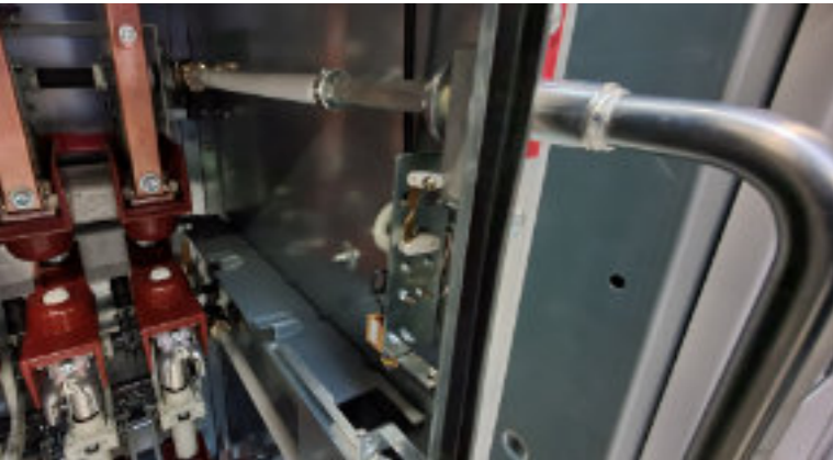
Der Kegelrad-Antrieb hinten rechts sorgt für ein reibungsloses Betätigen des Schaltgerätes bei geschlossener Tür. Er wird - wie auch andere manuelle und motorbetriebene Antriebe - bei SZM gefertigt.
