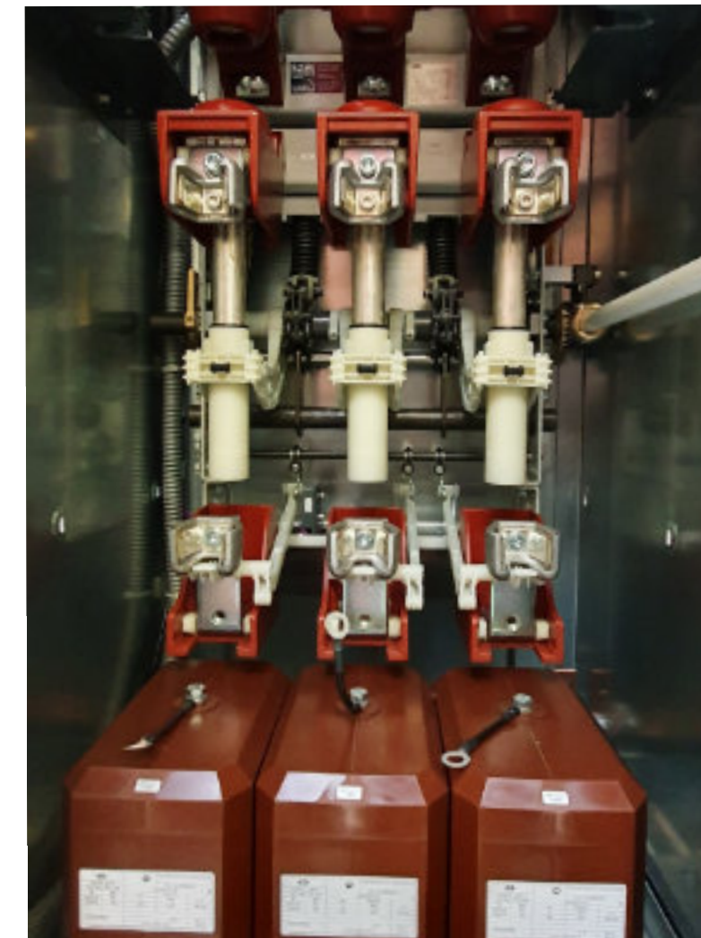
In die SAM integriert werden meist Schublasttrennschalter C3. Die früher von ABB/Calor Emag hergestellten Lasttrennschalter werden heute durch SZM gefertigt.
