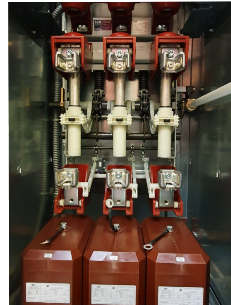
In die SAM integriert werden meist Schublasttrennschalter C3. Die früher von ABB/Calor Emag hergestellten Lasttrennschalter werden heute durch SZM gefertigt.
