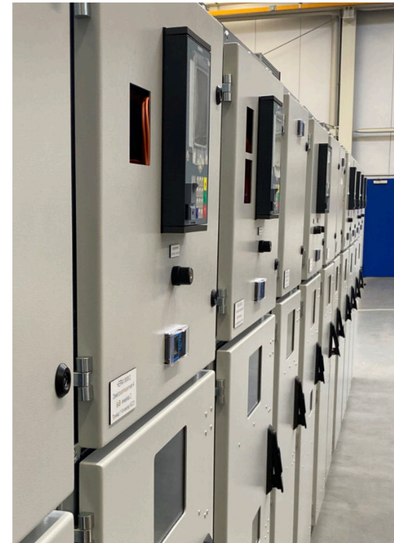
Die Mittelspannungsschaltanlage SAM ist vor allem eines: kompakt. Mit ihrer extrem geringen Bautiefe ist sie um ein Fünftel kürzer als herkömmliche luftisolierte Schaltanlagen und damit ideal für den Einsatz z.B. in Containern.
