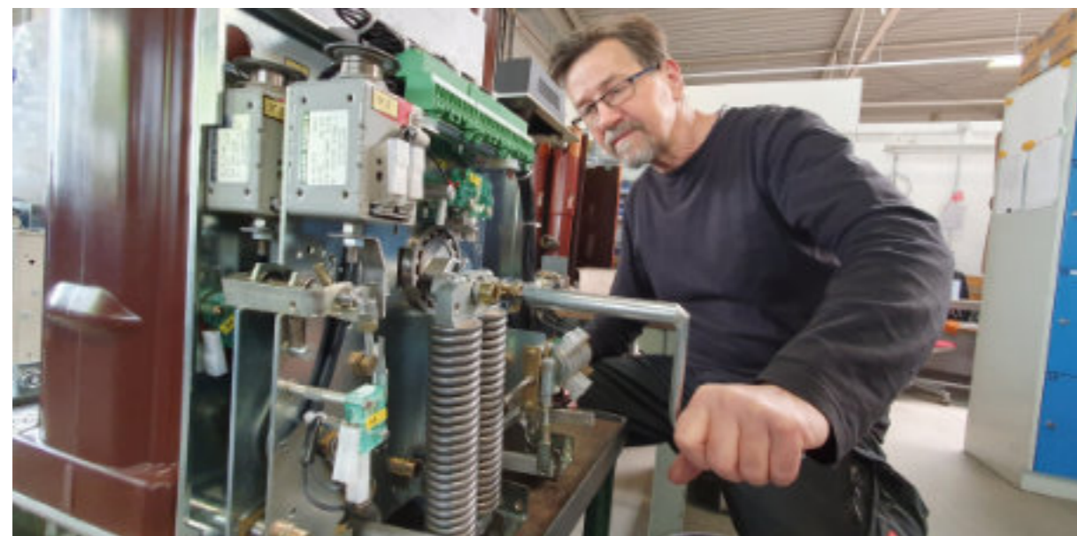
SZM übernimmt die Wartung und Inspektion an MS-Schaltgeräten, hier z.B. die Wartung eines Vakuum-Leistungsschalters Typ NVL von Ormazabal. / SZM provides maintenance and inspection services for MV switchgear. Here servicing of an NVL vacuum CB from Ormazabal.
